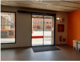
TR9 Instal·lació porta automàtica. PIU
