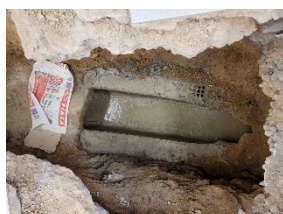
TR5 Reparació clavegueram planta 0.
