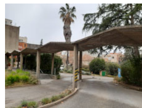
TR5 Sanejament porxada unió edificis TR5-TR7. PIU
