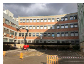
TR5 Pintura façanes.
