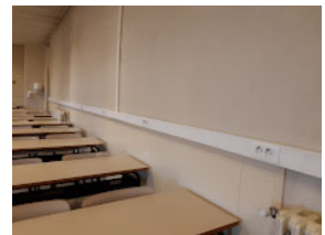
TR1 Instal·lació endolls a aules.
