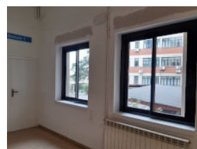
TR6 Substitució finestres vestíbul.
