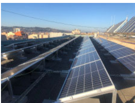
TR3 – TR5 Instal·lació plaques fotovoltaïques.
