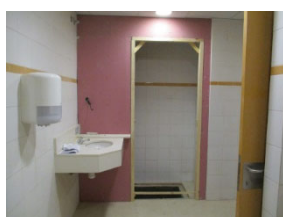
TR30 Instal·lar bomba de buidatge. PIU
