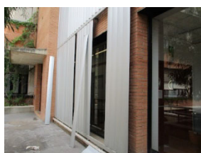
TR45 Substitució suport lames parasol. PIU
