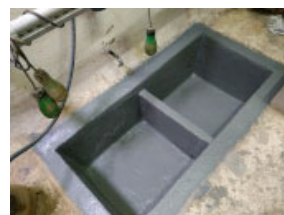
TR4 Impermeabilització fossa bombes inundació.
