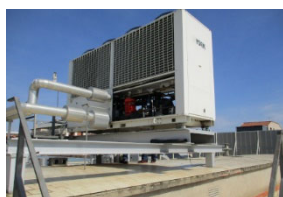
TR5 Reparació refredadora.
