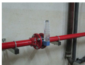
TR4 Instal·lació cabalímetre grup pressió BIEs. PIU
