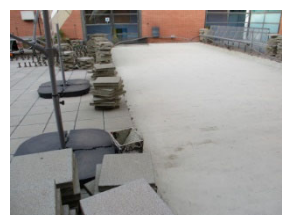
TR8 Impermeabilització patí interior.
