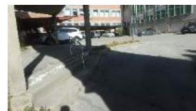
CAMPUS Instal·lació de baranes TR5
