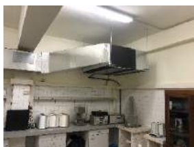
TR7 Substitució màquina AC laboratoris 104. PIU
