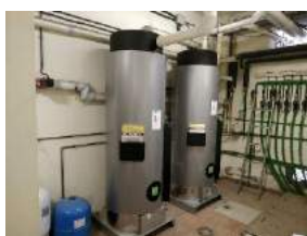
TR5 Substitució caldera- acumulador Servei d'Esports.
