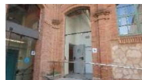
TR2 Modificació entrada porta de vidre.
