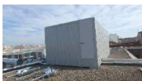
TR8 Substitució panells casetons clima. PIU
