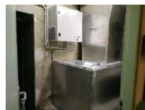
TR5 Canvi de turbines plantes S, 0,1 i 2. PIU
