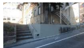
CAMPUS Instal·lació de baranes TR5
