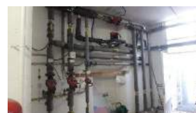
TR8 Instal·lació línia aigua calenta aules planta 2a. PIU
