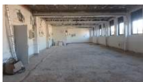
TR5 Enderroc espais 226- 235 per a futura aula. PIU
