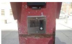
CAMPUS Instal·lació d'un nou sistema d'interfonia.
