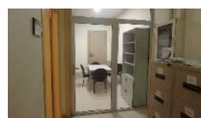
TR30 Construcció tancament zona direcció.
