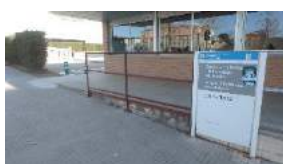
CAMPUS Instal·lació de baranes TR12
