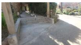
CAMPUS Instal·lació de baranes TR7
