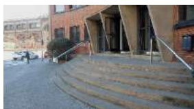
CAMPUS Instal·lació de baranes TR10
