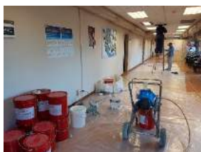
TR10 Pintura ignífuga planta 2. PIU
