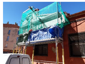
TR30 Reparació de goteres.
