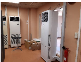
TR10 Clima nou dels servidors, planta 2. PIU
