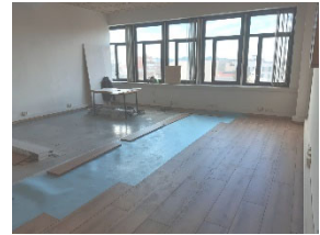
TR5 Remodelació espais Construcció, planta 3.
