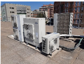
TR7 Substitució màquines aire condicionat P0,P1 .
