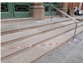
TR1 Rehabilitació escala entrada. PIU
