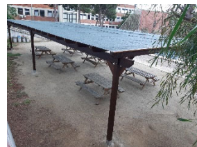
TR45 Construcció pèrgola.
