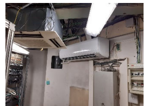
TR10 Clima nou del Rack, planta S1.
